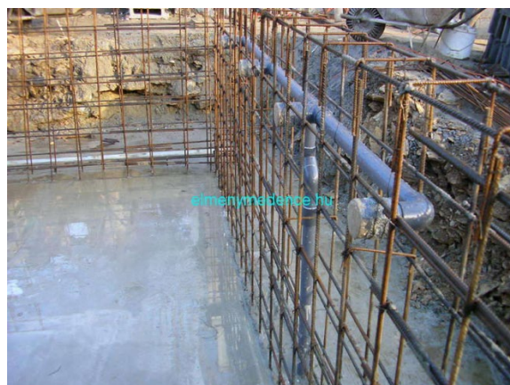
242. ábra Vasszerelés között vezetett PVC medencevíz cső
