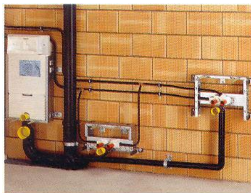
Előfalas berendezéselemek felszerelése
