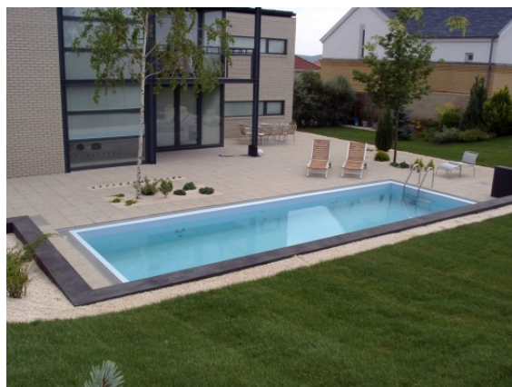
232. ábra Beton medence fóliaburkolással
