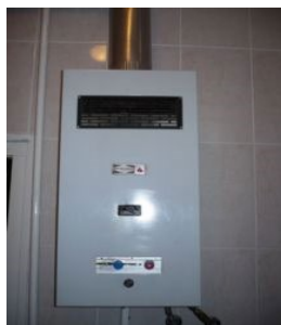
180. ábra Kéményes átfolyó üzemű vízmelegítő 12 l/perc
