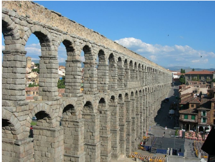
1. ábra Falazott vízvezeték magasan vezetve
