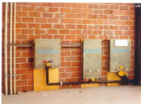
Előfalas berendezéselemek felszerelése
