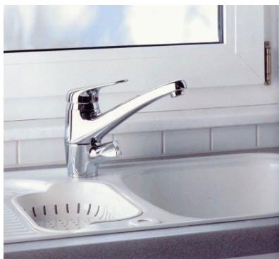
64. ábra Nyitható ablak alatti mosogató lehajtható csapteleppel
