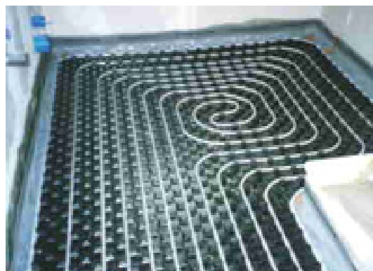
73a. ábra Csőrögzési módok különféle rendszereknél
