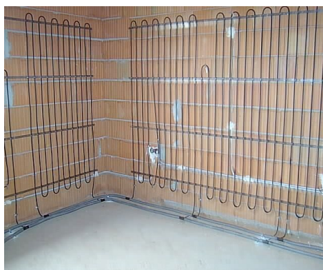
81.ábra Falfűtés függőleges és vízszintes csővezetéssel
