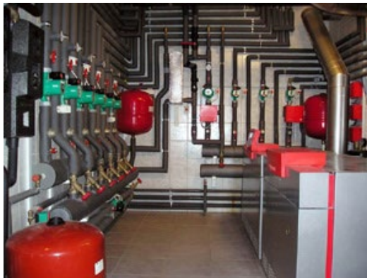
156. ábra Gáztüzelésű kazánház és hőközpont
