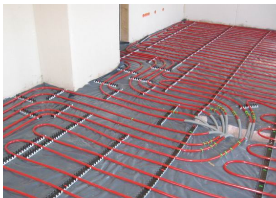
73a. ábra Csőrögzési módok különféle rendszereknél
