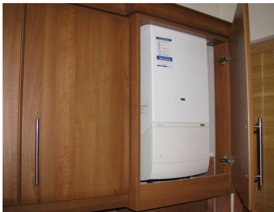
154. ábra Falikazán elhelyezése lakáson belül
