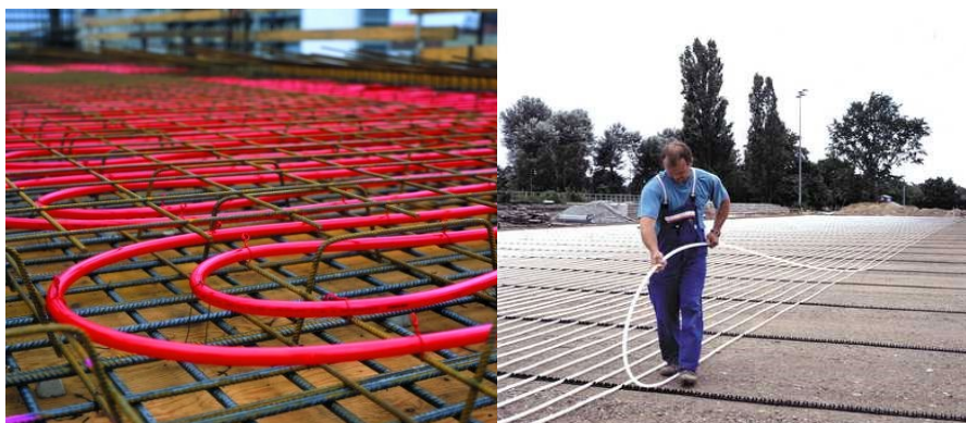
90. ábra Csövezés elhelyezése a vasbeton szerkezetbe betonzás előtt
