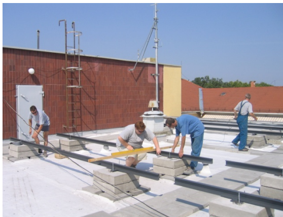
tartósínek és terhelő betontömbök elhelyezése
