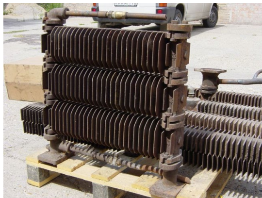
49. ábra Bordáscső fűtőtestek lemez és öntvénybordával
