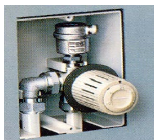
300. ábra Helyiségbe elhelyezett áramköri termosztatikus szelep
