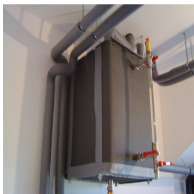
279. ábra Drain-back tartály kialakítása
