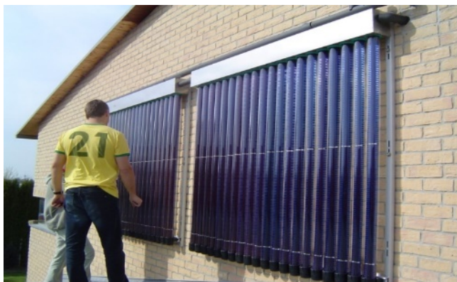
267. ábra Vákuumcsöves napkollektorok elhelyezése függőleges falfelületen
