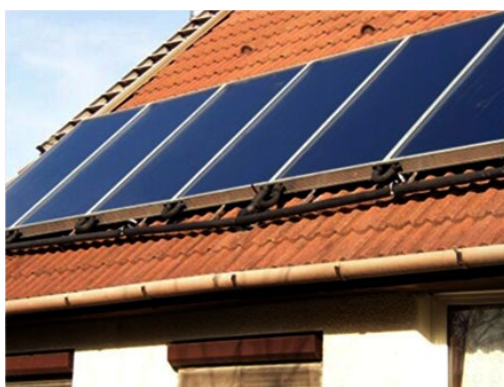
263. ábra Tetőre szerelt síkkollektorok
