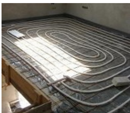
73b. ábra Csőrögzési módok különféle rendszereknél
