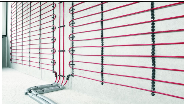
84. ábra Nedves szerelésű falfűtés és osztó elhelyezése
