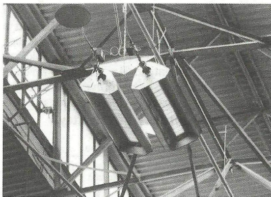
184. ábra Mennyezetre függesztett infrasugárzók
