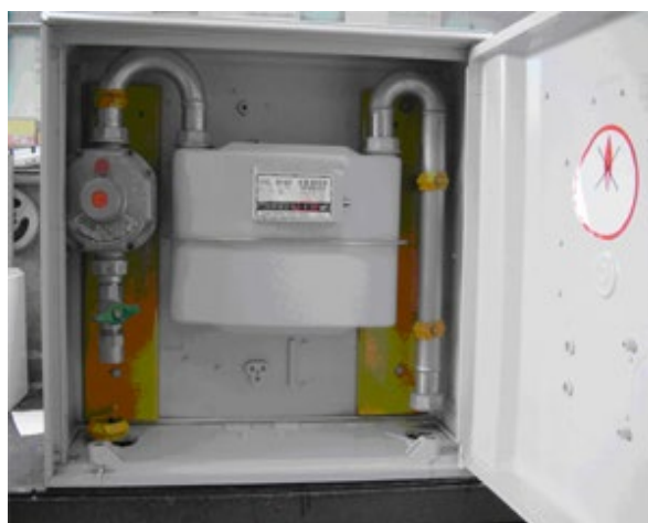
79. ábra A házi nyomásszabályozó és mérő együttes szerelése
