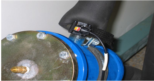
Nymásmérés csatlakozás szervízömlővel
