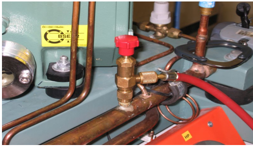
Nymásmérés csatlakozás szervízömlővel
