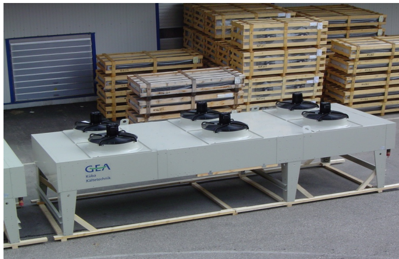
91. ábra nagyméretű léghűtéses kondenzátor
