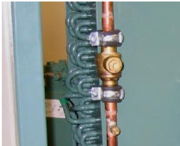
46. ábra csővezeték bilincsezése szakaszoló szerelvénynél
