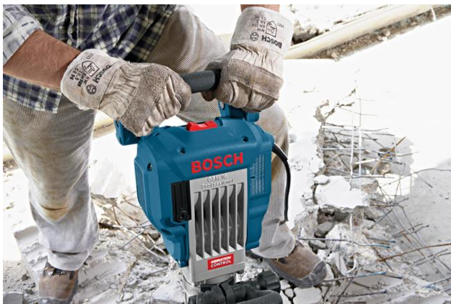
8. ábra Bontókalapáccsal végzett munka
